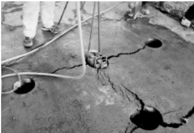
図 - 3 油圧シリンダによる破碎
