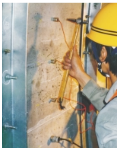
写真 - 17 AE打撃法によるコンクリート内部欠陥調査状況
