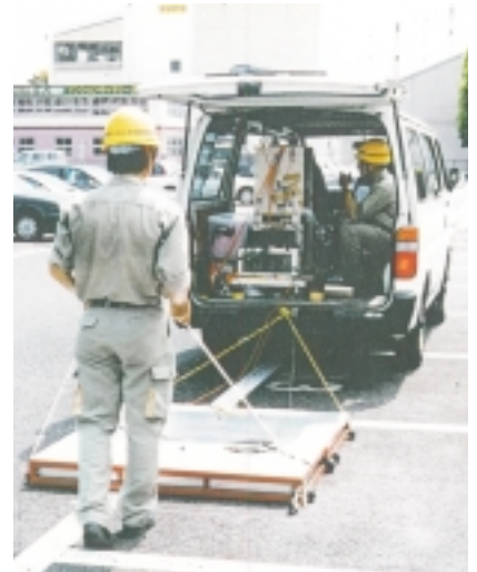
写真 - 7 レーダによる金属類地盤汚染調査状況
