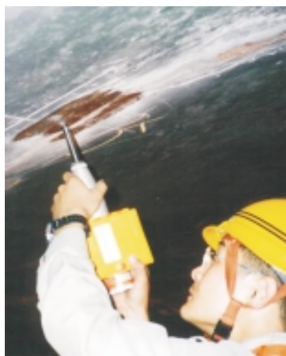
写真 - 16 反発硬度法によるコンクリート強度判定
