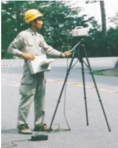
写真 - 2 熱赤外線映像法による吹付のり面調査状況
