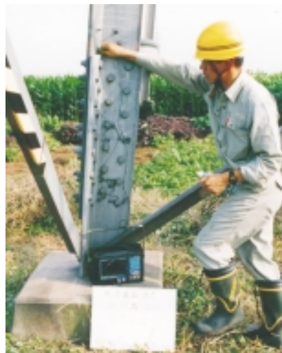
写真 - 14 超音波法による鉄塔のアンカーアングル長計測状況
