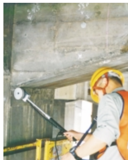
写真 - 18 自然電位法による新幹線高架橋の鉄筋発錆調査状況
