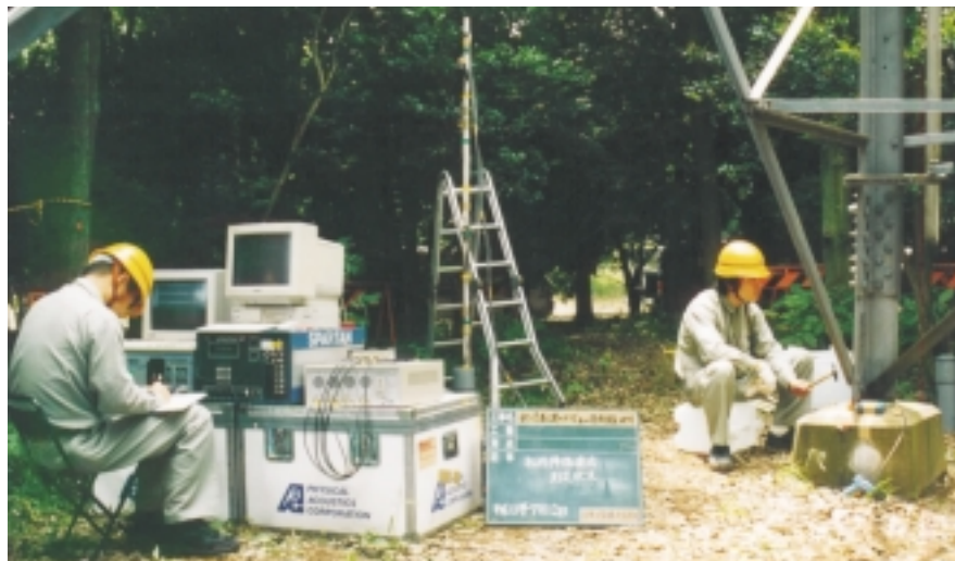
写真 - 11 孔内弾性波法による鉄塔基礎コンクリートの形状調査状況
