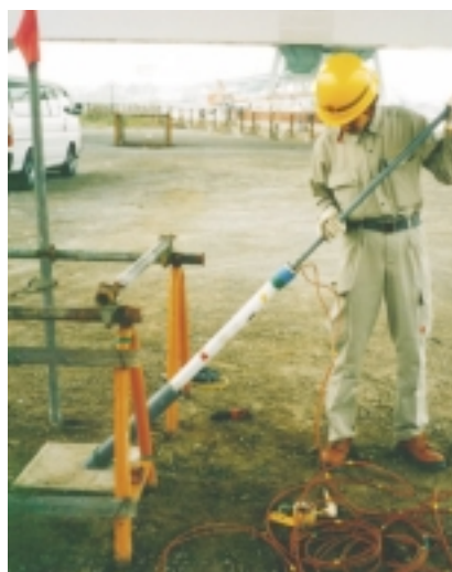
写真 - 9 ポアホールレーダアンテナの斜めボーリング孔への挿入状況
