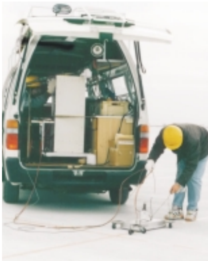
写真 - 5 空港舗装版下の空洞探査状況
