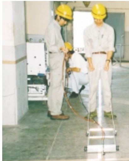
写真 - 6 レーダによる建築基礎形状・配筋計測状況
