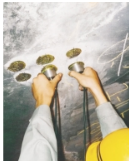
写真 - 12 超音波法によるコンクリート内部欠陥調査状況
