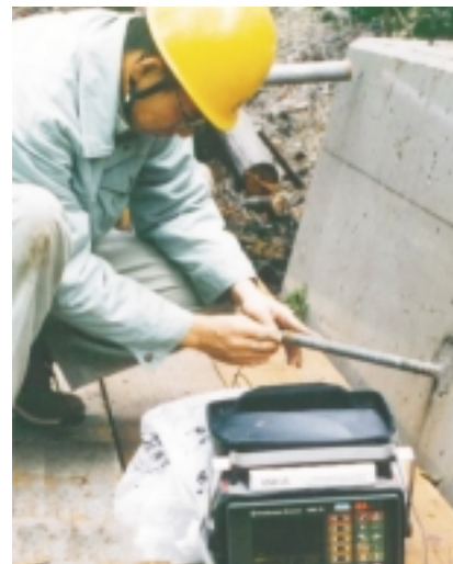
写真 - 15 超音波法によるロックボルト長の計測状況
