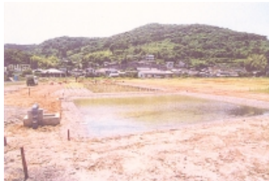
写真 - 3 施工直後の施設の全景
