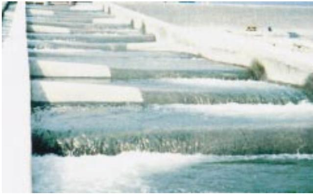
写真 - 3 ハーフコーン型魚道の流況
