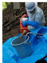
＜水中ポンプで投入＞ トレーサー物質の投入
