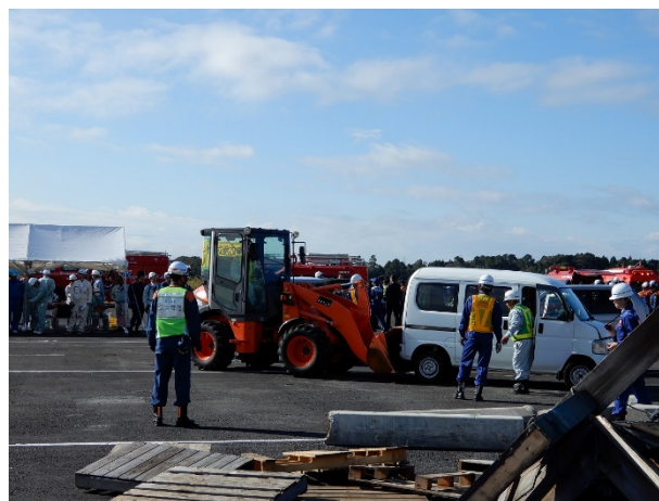
道路啓開訓練の様子
