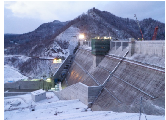
既設ダム下流かさ上げによるダム再開発事例
