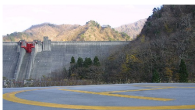
場外離着陸場（ダム区域内）
