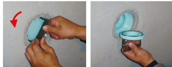
▲受圧板ユニットの交換により**消散弁を再使用可能**
