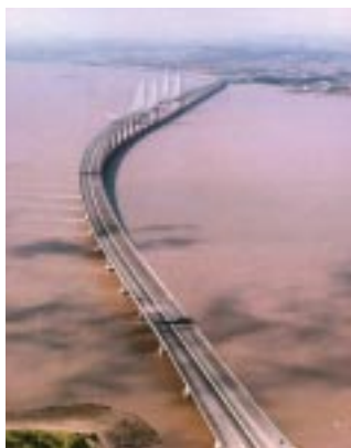
イギリスでのPFI事業（第二セバーン橋）
