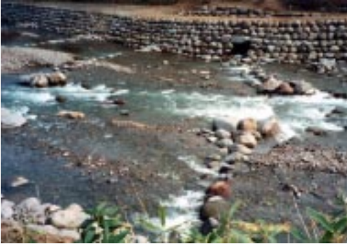
低水水制により創造された低水路の様子
