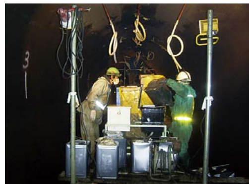
写真-14 発泡ウレタン注入状況
