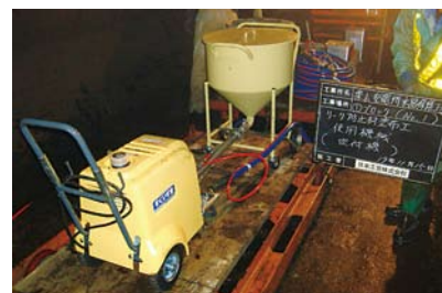
写真-9 吹き付け設備
