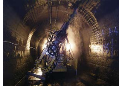
写真-8 ラドスによる注入孔削孔状況
