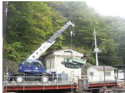
写真-5 トンネル内機械搬入状況
