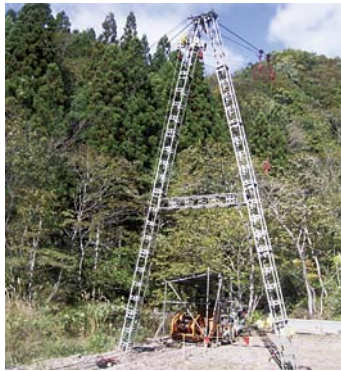
写真-2 1t ケーブルクレーン
