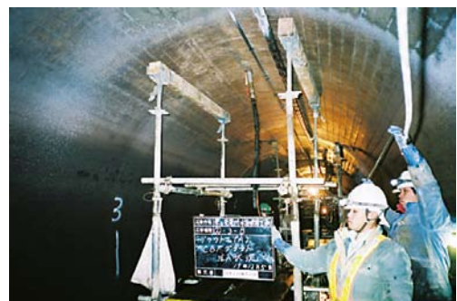
写真-12 CBFグラウト施工状況
