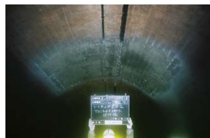
写真-10 吹き付け施工後
