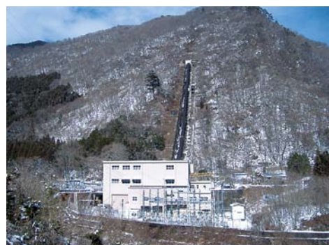
写真－1 栗山発電所全景
