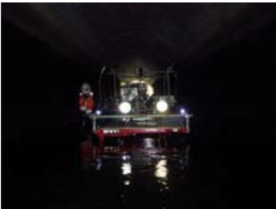
図-12 Sトンネルでの計測状況
