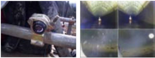
図-6 水中カメラの設置とカメラによる前方監視画像
