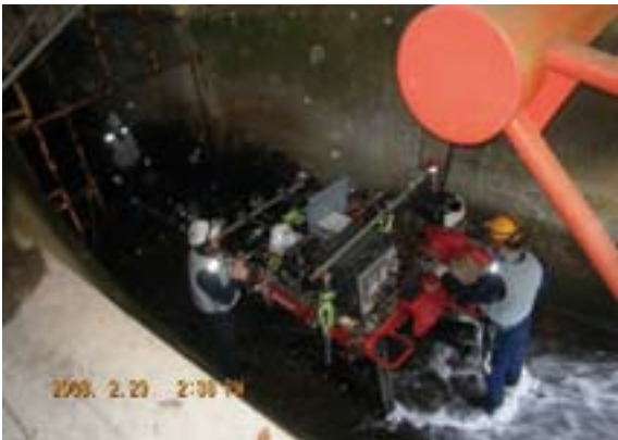
図-13 Tトンネル 進入前の準備状況
