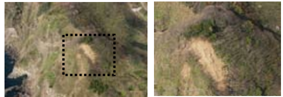
図-8 海岸部斜面崩壊箇所の被害状況確認（右拡大図）
