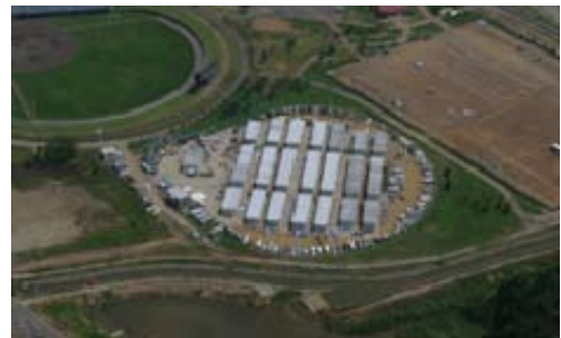
図-13 仮設住宅の使用状況の確認
