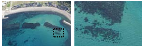
図-7 地震により崩壊した人工リーフ（右拡大図）
