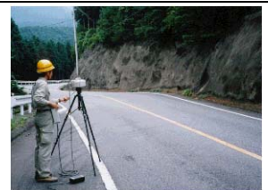
写真-4 熱赤外線画像計測状況(固定法)
