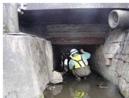
写真-1 点検状況
