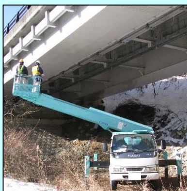
リフト車による近接目視
