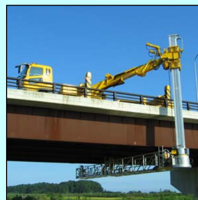
橋梁点検車による近接目視
