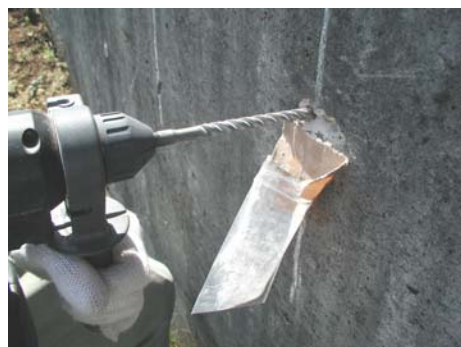
写真-1 ドリル削孔状況
