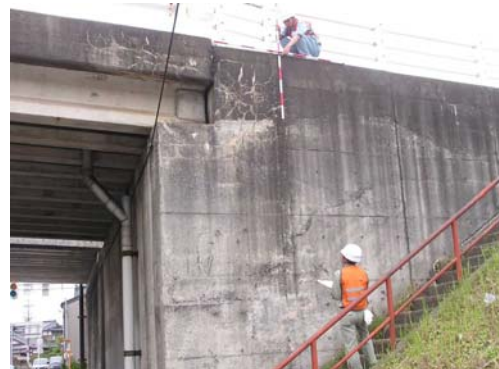
写真-1 ASR 劣化構造物の目視点検
