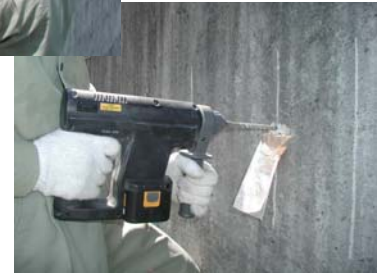
写真-2 ドリル削孔粉の採取
