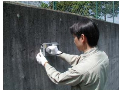
写真-1 配筋調査 (小型レーダ)
