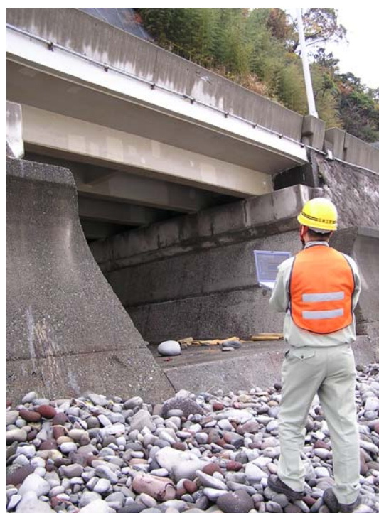
写真-1 現地点検状況
