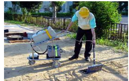
図-3 ヘリウム検知式漏洩検査状況
