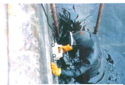
干満帯における配筋調査
